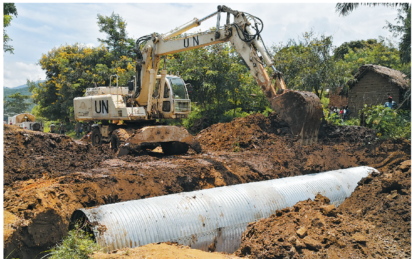
当地时间3月14日,中国第23批赴刚果(金)维和工兵分队乌维拉分队历时20余天,克服恶劣天气等困难,成功修复卢森达被暴雨冲毁的桥梁,受到联刚稳定团工程处高度赞扬。图为维和官兵驾驶挖掘机埋设排水管涵。
